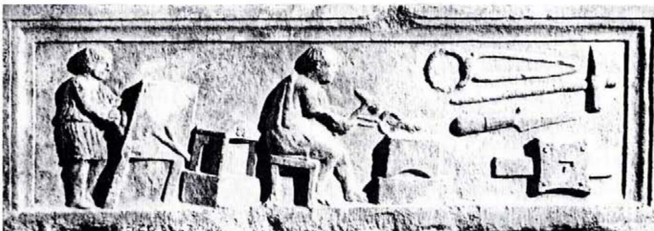
Aquileia: stele sepolcrale romana del I sec. d.C. con rappresentazione dell'officina di un fabbro. Alle spalle del maestro un garzone attizza il fuoco della forgia con un mantice; a destra sono rappresentati alcuni attrezzi ed una serratura.
