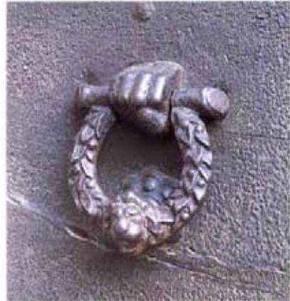
**2. Maniglie ad anello modificato o a forma simmetrica:** sono varie tipologie accomunate dall'aver un asse di simmetria verticale, che corre tra fulcro e battitoio e che divide la maniglia in due metà simmetriche. Prevalentemente sono in ferro battuto, ma specialmente in Italia, dal Rinascimento in poi, compaiono anche in bronzo.
